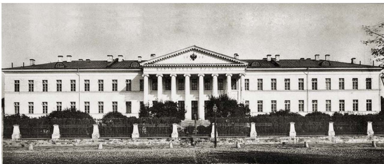
Главный корпус Мариинской больницы. Построен в 1803–1805 годах по проекту И. Д. Жилярди. Фотография. 1890–1900. Москва, архив Центра историко-градостроительных исследований (ЦИГИ)
